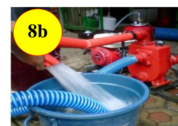
Pindahkan minyak kedalam drum dengan menggunakan pompa / skimmer
